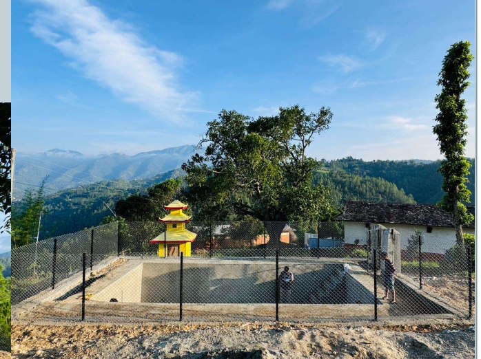
टूटीपिपल पोखरी संरक्षण कार्य सन्धिखर्क १० अर्घाखाँची
