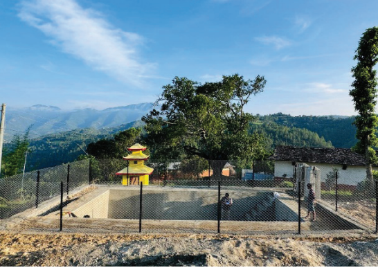
जल पुनर्भरणको लागि पोखरी संरक्षण टुटिपिपल पोखरी निर्माण सन्धिखर्क-१०, अर्घाखाँची
