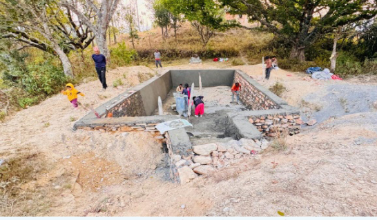
जल पुनर्भरणको लागि लामापोखरा र देशन्तरी पोखरी निर्माण सन्धिखर्क १० अर्घाखाँची
